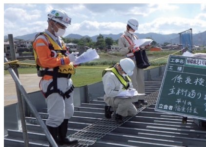
1級土木施工管理技士の資格を持つ社員（左）が、公共工事の品質検査に対応
