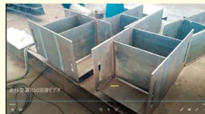
動画で走行装置の溶接の検査
