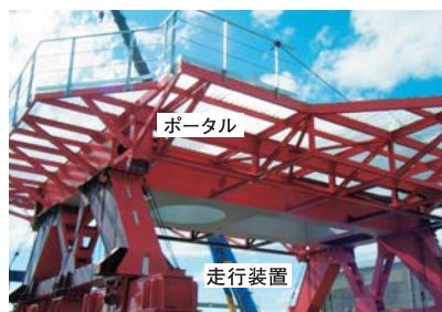
走行装置・ポータル仮組
