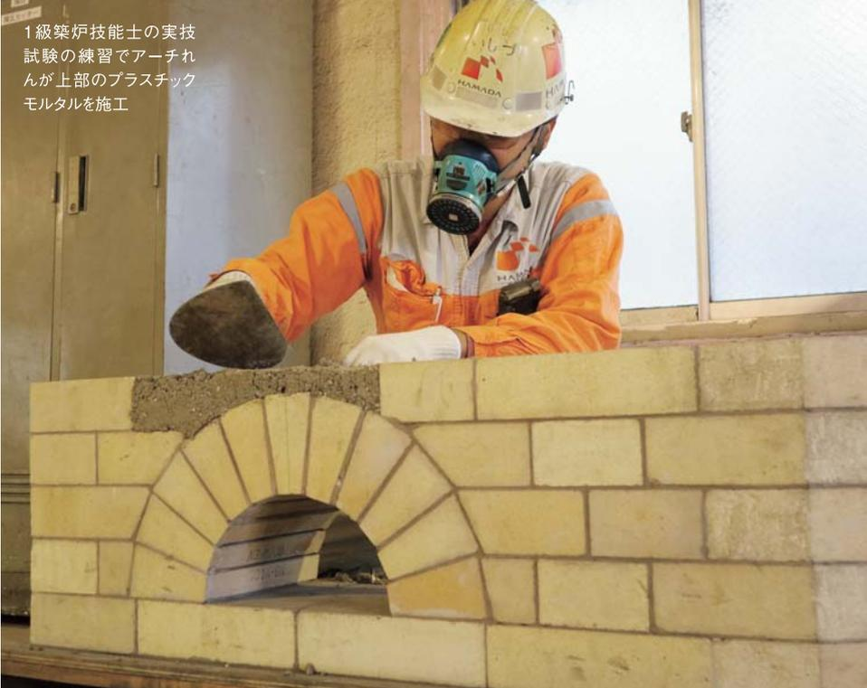
1級築炉技能士の実技試験の練習でアーチれんがが上部のプラスチックモルタルを施工
