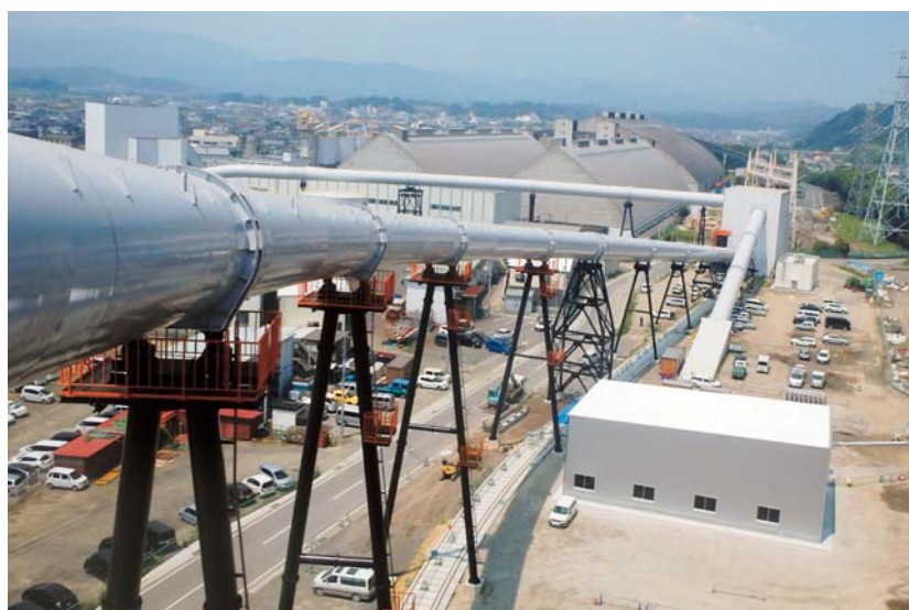
搬送プラント設計グループ実績写真 福島復興電源 石炭コンベア設備設置工事
