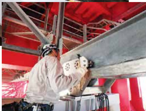
▲港大橋*の橋梁を点検する、「移動台車」のメンテナンスを担当。機械装置の設備上の注意に加え、高速道路を走行する車や海の上の高所のため、メンテナンスの際、工具の落下防止対策など、安全には細心の注意を払っています
