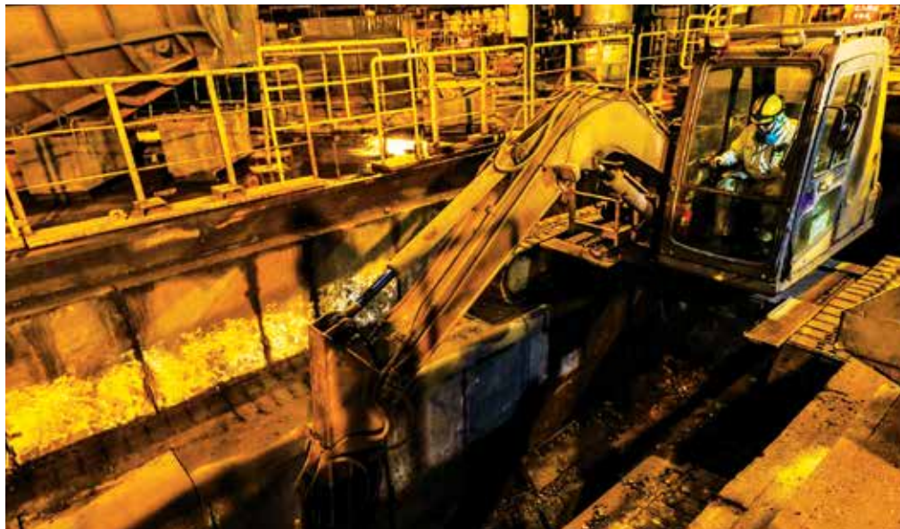
▲耐火物を重機で解体中の佐野班長。後でスコップではねる必要のない「さらい」のうまさか技能の高さの証し
