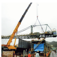
▲スタッカを納入先で据付
