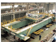
天井クレーン
