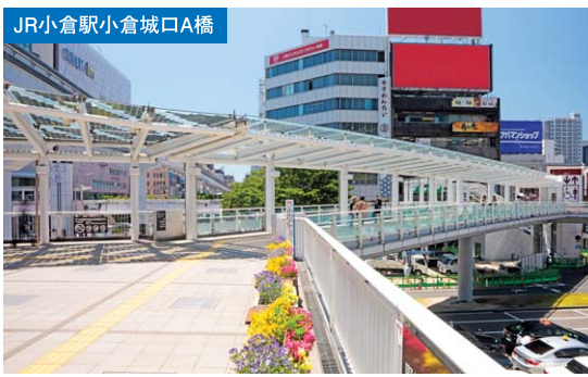
JR小倉駅小倉城口A橋 今年3月にJR小倉駅小倉城口ペDESTリアンデッキA橋および新橋上に鉄骨設置を完了。JR小倉駅からシロヤのパン屋方面を往来する際は、ぜひルーフ下を歩いてください。
