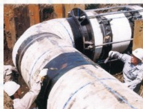
▲熱収縮シートの施工現場
