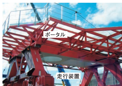
走行装置・ポータル仮組
