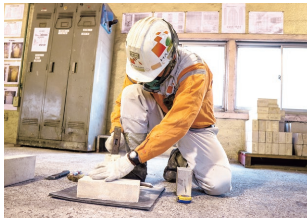
長方形のれんがに罫書きして、40枚ぐらい割って削って磨き、垂直・水平に施工するため神経を使いました
