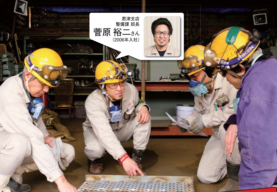
整備の仕事は技術だけでなく、各現場の担当者とのコミュニケーションも重要。材料の加工法もしっかり確認する
