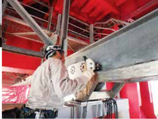
▲港大橋*の橋梁を点検する、「移動台車」のメンテナンスを当社が担当。機械装置の設備上の注意に加え、高速道路を走行する車や海の上の高所のため、メンテナンスの際、工具の落下防止対策など、安全には細心の注意を払っています
