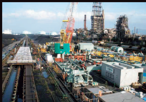
仮置き場として借用したヤード
